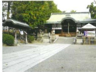
仮殿・仮拝殿建設地
