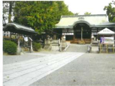
仮殿・仮拝殿建設地
