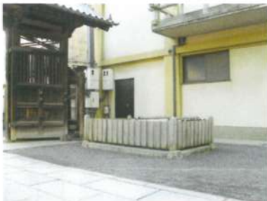
臨時手水舎設置箇所
