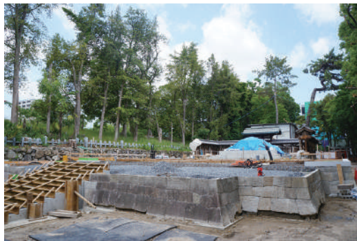
基礎工事及び石垣設置
