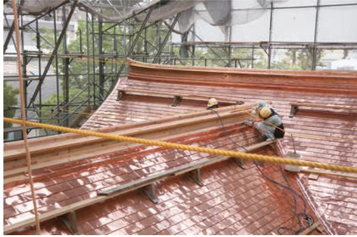
幣殿・拝殿屋根銅板葺工事
