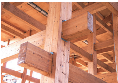
「大屋根リング」で用いられた貫接合
